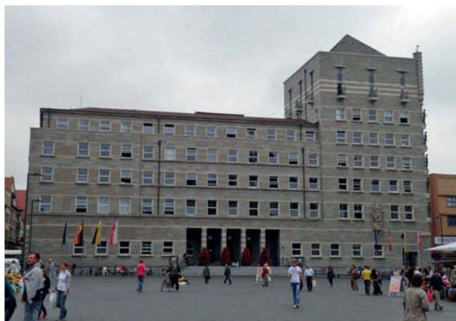
Rathshof Halle: Sitz des Oberbürgermeisters.
