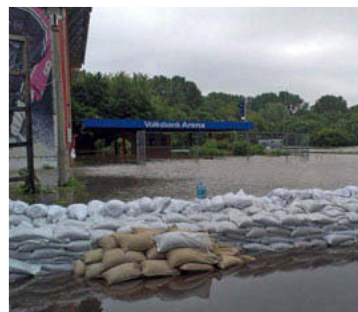
Sicherung des Gimritzer Damms mit Sandsäcken (Foto: Felix Peter).
